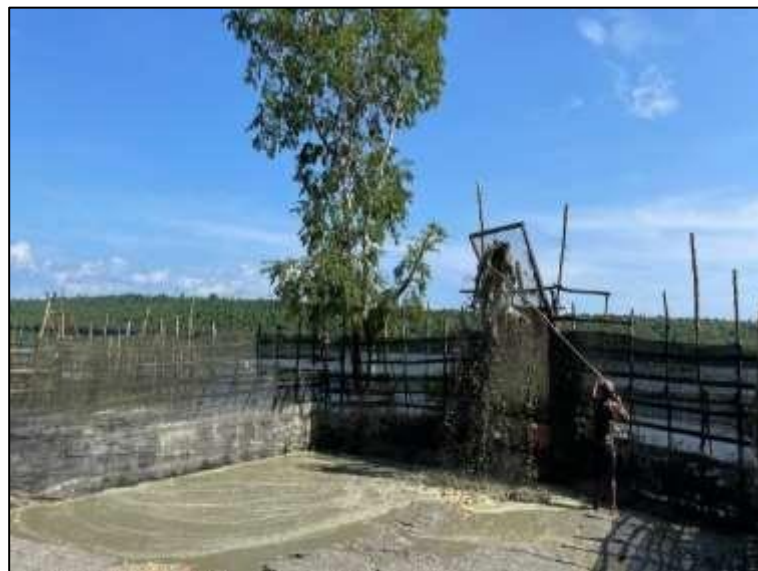
Gambar 4. Penampungan dan Timbunan Pasir
