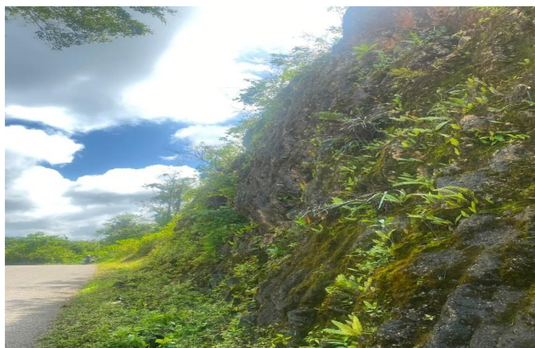
Gambar 6. Kondisi Air Tanah (Dokumentasi Lapangan, 2026)
