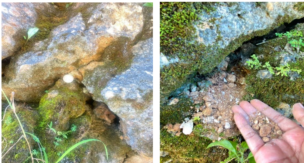
Gambar 5. kondisi bidang kekar dan isian kekar (Dokumentasi Lapangan, 2026)
